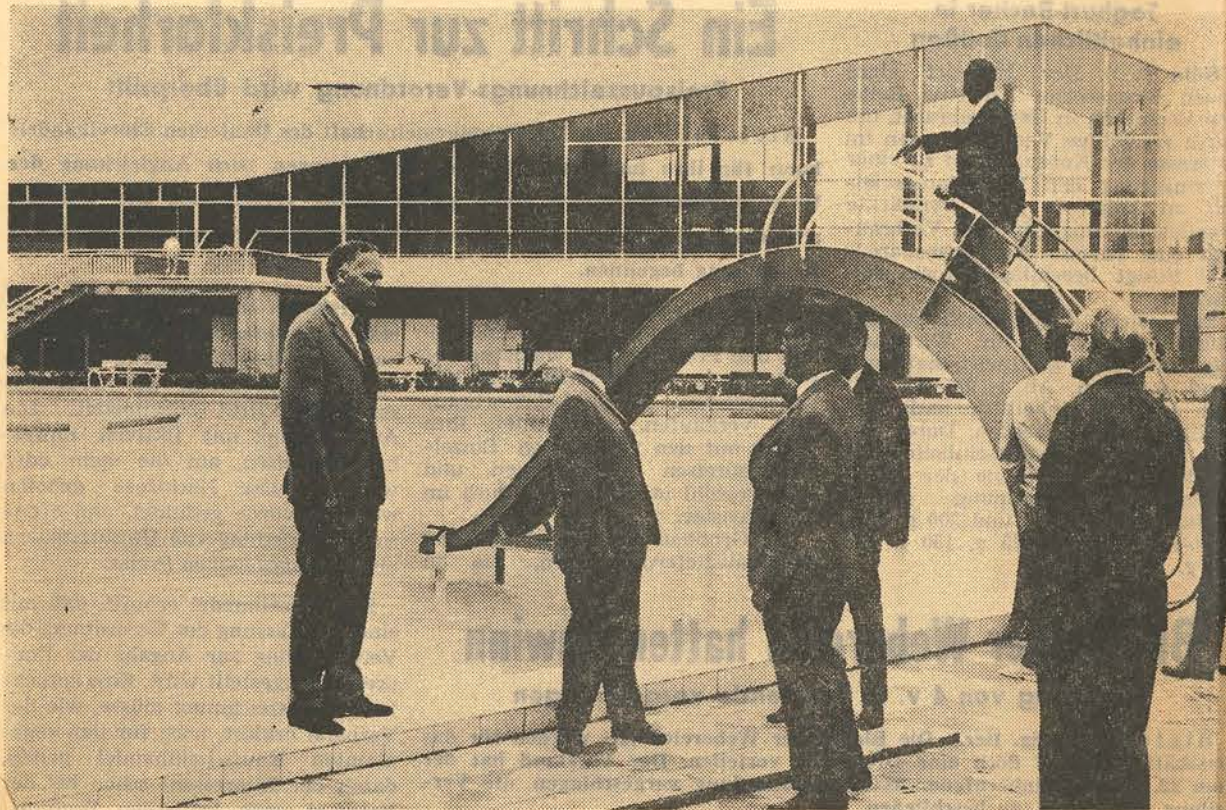
Während einer Besprechung wenige Tage vor der Eröffnung des Braker Hallen- und Freibades: Architekt Dipl.-Ingenieur Günther Klusmann (Bielefeld), Amtsdirektor Krahmüller, Beigeordneter Wetehoff und Amtmann Rieger (von links). Bild: Fischer
